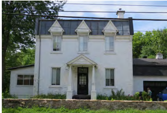
IMG_0775.JPG, juin 2015 Maison mansardée
