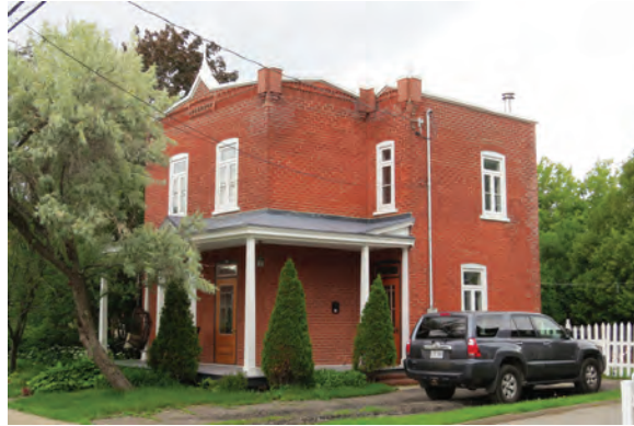
IMG_0544.JPG, juin 2015 Maison à toit plat
