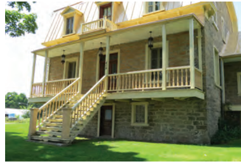
IMG_3271.JPG, juin 2015 Maison à toit plat
