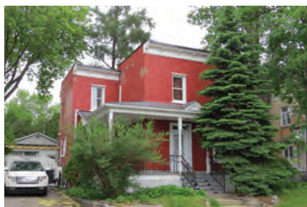
IMG_0430.JPG, juin 2015 Maison à toit plat
