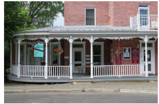
IMG_0620.JPG, juin 2015 Maison à toit plat
