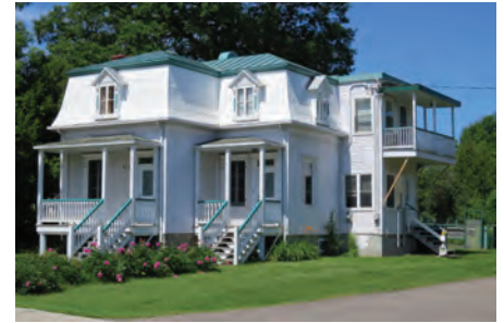
IMG_0690.JPG, juin 2015 Maison mansardée
