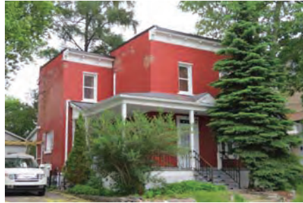
IMG_0423.jpg, juin 2015 Maison à toit plat
