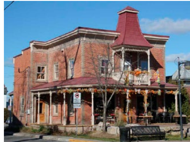
L'un des bâtiments principaux inventoriés à Sainte-Anne-des-Plaines, le 169, boulevard Sainte-Anne, en raison notamment de son intérêt architectural et de sa localisation au sein d'une importante concentration d'architecture ancienne.
