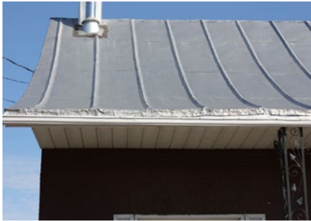
Tôle à baguettes. 205, 2 e Avenue, Sainte-Anne-des-Plaines.
