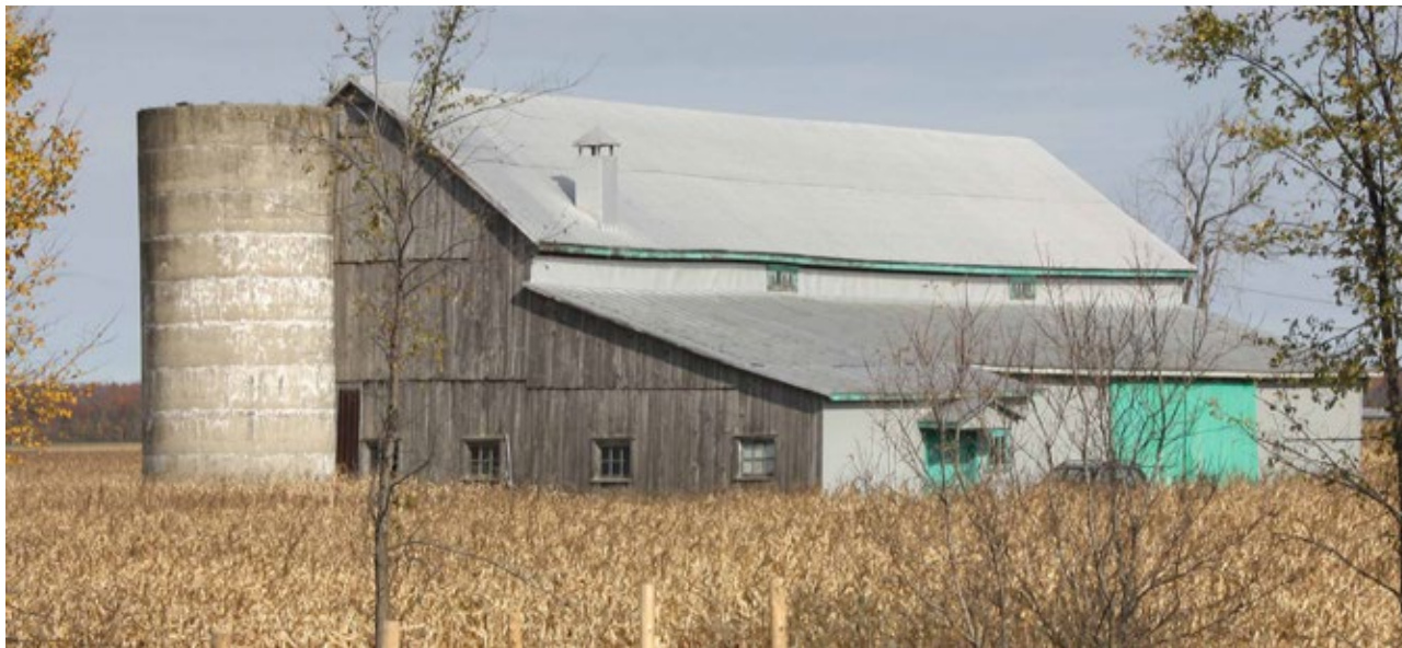
Grange-étable avec appentis. Les murs d'un silo en béton sont encore conservés. 93, rang du Trait-Carré, Sainte-Anne-des-Plaines.
