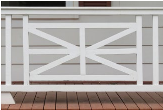
Exemple de garde-corps à barreaux en croix de saint André. 6-8, rue Saint-Joseph, Sainte-Thérèse.
