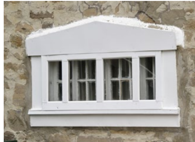
Soupirail à petits-bois, une composante très rare. Maison J.-A.-Chapleau, 104-106, rue Saint-Charles, Sainte-Thérèse.
