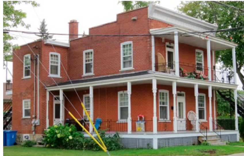
Exemple de maison à toit plat, la maison Lecompte au 113-115, rue Blainville Ouest, Sainte-Thérèse.
