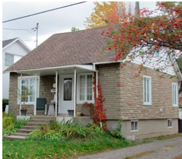
Exemple de maison Wartime Housing, le 8, rue Hertel, Sainte-Thérèse.
