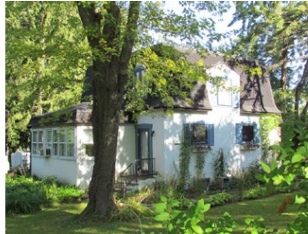
Exemple de maison à fausse mansarde, le 377, chemin de la Grande-Côte, Rosemère.
