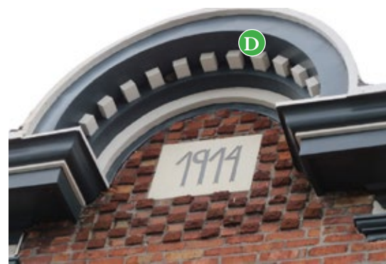
Couronnement circulaire, corniche à denticules (D), jeux de briques en relief et pierre millésimée. 77-79, rue Saint-Charles, Sainte-Thérèse.
