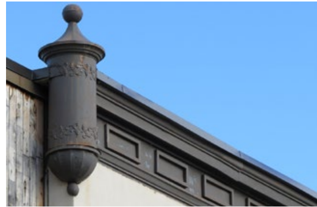
Un modèle tout à fait exceptionnel d'urne (à l'extrême gauche) en tôle délimitant une frise également en tôle, ornée d'appliches moulurées. 41, rue Blainville Ouest, Sainte-Thérèse.
