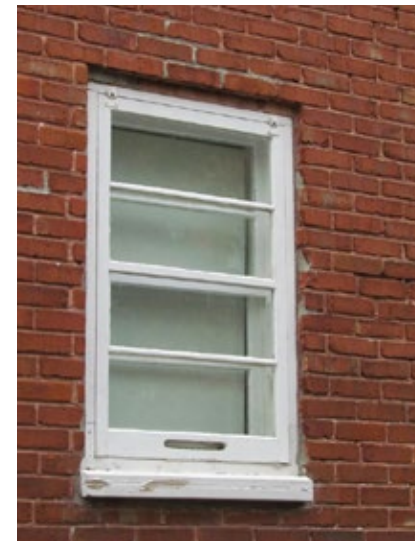
Contre-fenêtre à barreaux horizontaux devant une fenêtre à guillotine. 2-4, rue Tassé, Sainte-Thérèse.
