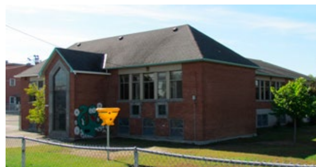
Exemple d'édifice public, l'école Saint-Edmond au 445, boulevard du Curé-Labelle, Blainville.
