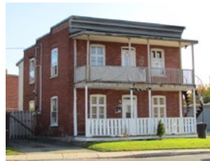
Exemple d'édifice à toit plat, le 26-28, rue Dubois, Sainte-Thérèse.
