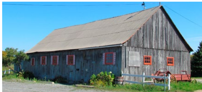
Intéressante grange-étable au toit à deux versants courbés, probablement l'une des plus anciennes de la MRC, puisqu'elle daterait des environs de 1850. Elle offre de surcroît une très bonne intégrité architecturale. 303, chemin de la Côte-Saint-Louis Est, Blainville.
