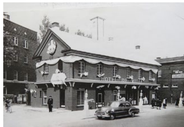
Le Centre J.-Olindo-Gratton tel qu'il apparaît vers 1954. L'abri et le balcon de la façade ont été détruits. L'édifice conserve néanmoins, à ce moment, plusieurs éléments, notamment les fenêtres à battants à petits carreaux du second niveau, la fenêtre circulaire du mur pignon et la tour associée aux services des incendies. 30, rue Blainville Ouest, Sainte-Thérèse. SHGMI. C001 S2 SS1 D5.
