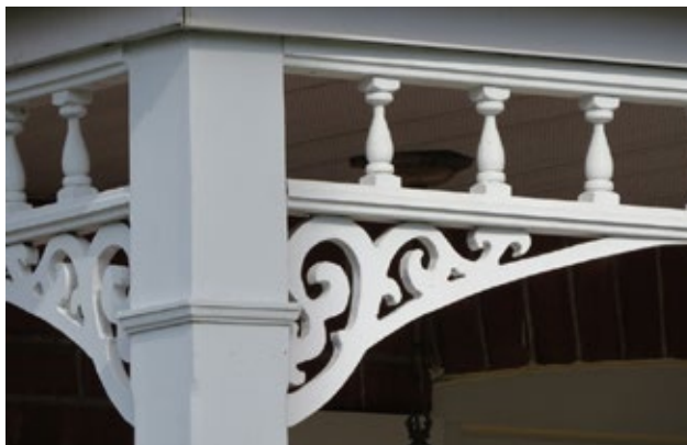
Lambrequins prenant la forme de mini balustres; en dessous: les aisseliers sont découpés à motifs à jour. 26, rue Morris, Sainte-Thérèse.
