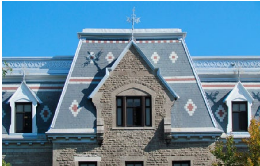
Revêtement polychrome d'ardoise sur le toit de l'ancien séminaire de Sainte-Thérèse, un agencement rarement utilisé en architecture publique. 6, rue Duquet, Sainte-Thérèse.
