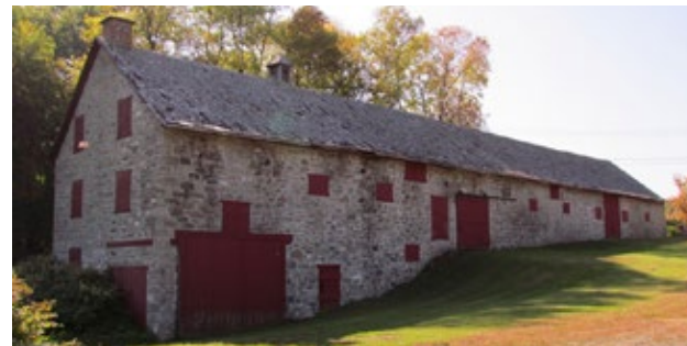
Exemple d'un édifice « hors type », la grange-étable du domaine Garth au 100, chemin de la Grande-Côte, Lorraine.
