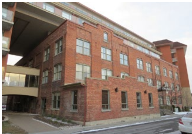
L'ancienne usine des Pianos Lesage. 15, rue Lesage, Sainte-Thérèse.
