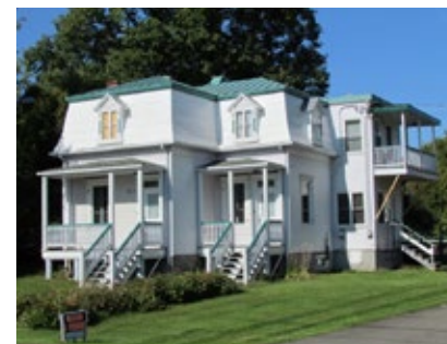
Exemple de maison à toit mansardé, le 523, chemin de la Grande-Côte, Rosemère.
