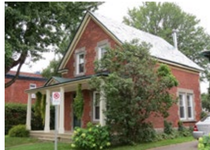
Exemple de maison à toit à deux versants droits d'influence néoclassique, la maison Wurtele au 25, rue Morris, Sainte-Thérèse.
