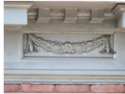
Détails (festons de guirlandes de fleurs) de la corniche de tôle représentée plus haut au 6-10, rue Turgeon, Sainte-Thérèse.
