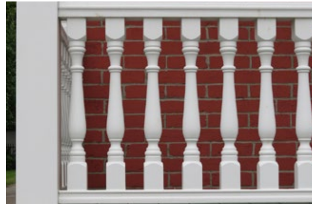
Balustrade en bois dont les balustres sont formés de barreaux découpés au 24-26, rue Saint-Joseph, à Sainte-Thérèse.
