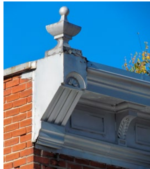
Console avec urne, et extrémité d'une corniche à consoles; tous ces éléments sont en tôle sur une structure de bois. 17-19, rue Saint-Lambert, Sainte-Thérèse.
