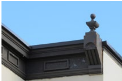
Console et urne à l'extrémité de la corniche du 41, rue Blainville Ouest, Sainte-Thérèse.
