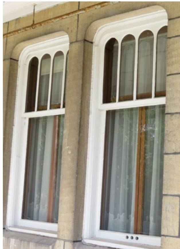
Fenêtre à battants à grands carreaux, l'un des modèles les plus usuels en architecture ancienne. Maison Williams-Miller, 475, rue Émile-Nelligan, Boisbriand.
