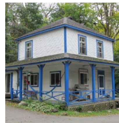
Exemple de maison cubique (d'inspiration Four Square Style), le 26, 49 e Avenue, Bois-des-Filion.
