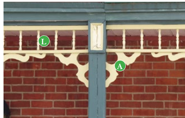
Lambrequins prenant la forme de fins fuseaux et aisseliers (A) découpés. 39-41, rue Saint-Charles, Sainte-Thérèse.
