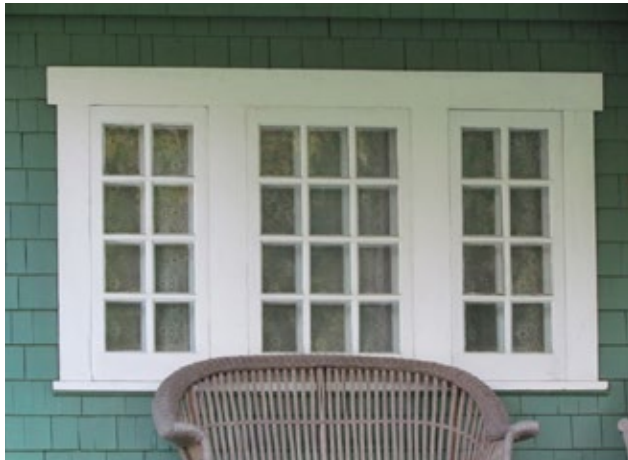
Fenêtres à battants à petits carreaux avec baies latérales. 312, rue Labelle, Rosemère.
