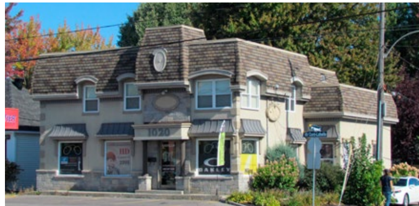
Exemple de maison à fausse mansarde, le magasin Jos.-Labelle au 1020, boulevard du Curé-Labelle, Blainville.
