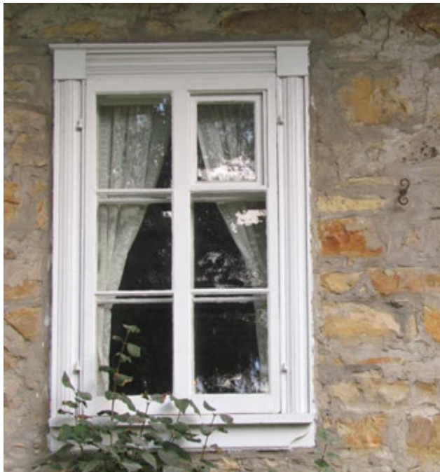
Fenêtre à battants à grands carreaux, l'un des modèles les plus usuels en architecture ancienne. Maison Williams-Miller, 475, rue Émile-Nelligan, Boisbriand.
