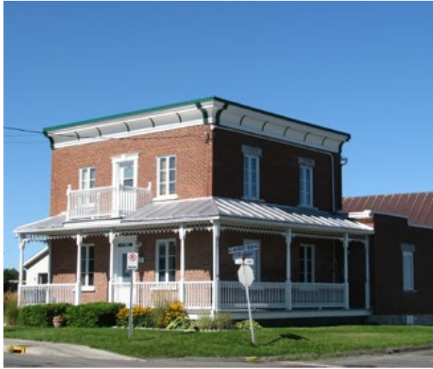
La maison Delorme-Lauzon au 69, boulevard Sainte-Anne, Sainte-Anne-des- Plaines.
