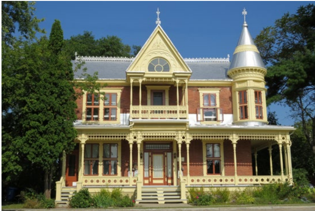
La maison du docteur Avila Larose (ou villa William-Brennan), en 2014. Elle présente un parfait état d'authenticité et offre le même aspect qu'à son origine, ce qui est véritablement exceptionnel, compte tenu de la qualité, de la fragilité et de la complexité de ses composantes architecturales ainsi que de leur finesse d'exécution. À voir au 10-12, rue Saint-Charles, Sainte-Thérèse.
