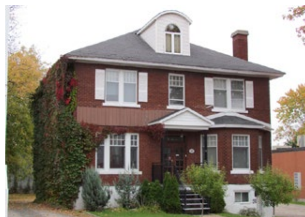
Exemple de maison cubique (d'inspiration Four Square Style), le 29-31, rue Turgeon, Sainte-Thérèse.
