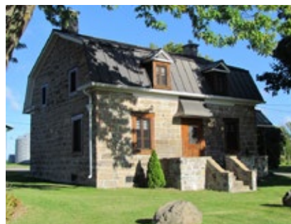
Exemple de maison à toit mansardé, la maison Dion au 3510, chemin de la Rivière-Cachée, Boisbriand.
