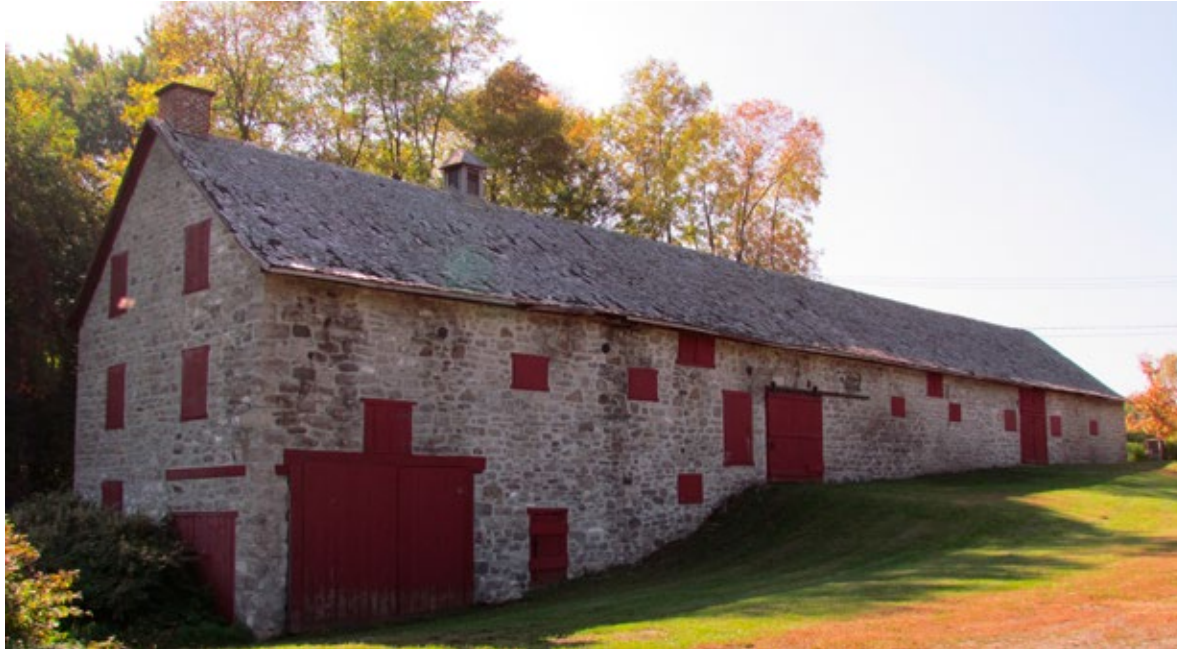
Grange-étable en pierre de la maison Garth, construite dans la dernière moitié du 19 e siècle, un genre de bâtiment extrêmement rare au Québec. 100, chemin de la Grande-Côte, Lorraine.
