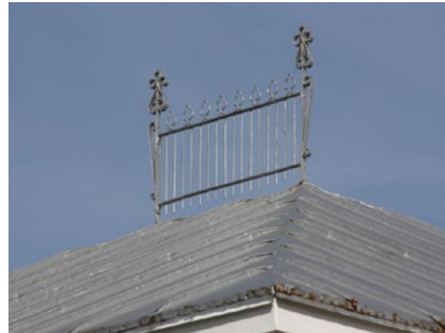
Balustrade de couronnement en fer ornemental au sommet du toit du 245, 5 e Avenue, à Sainte-Anne-des-Plaines.
