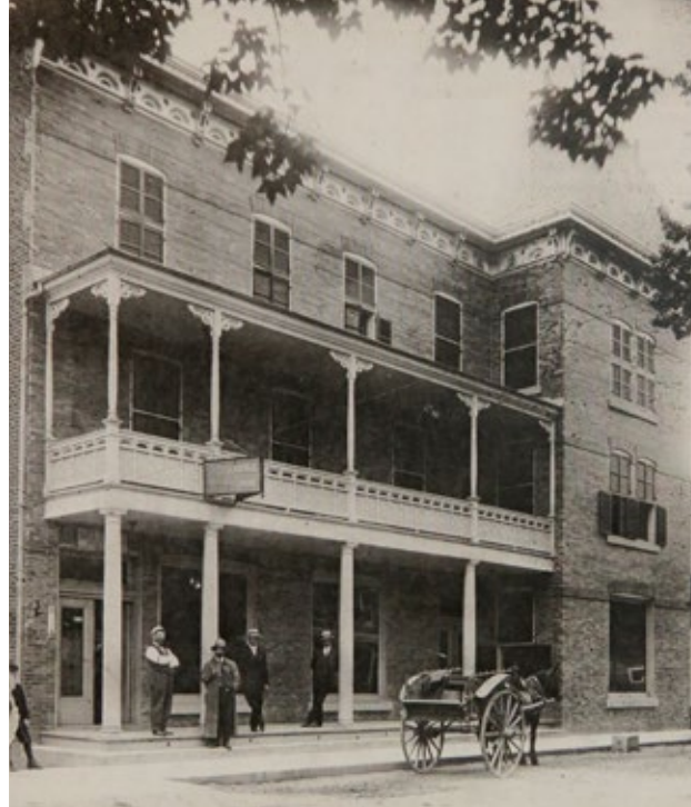
L'imposant Hôtel Blainville érigé en 1912, photographié sans doute peu de temps après sa construction. SHMI, C001, S2, SS1, D2.
