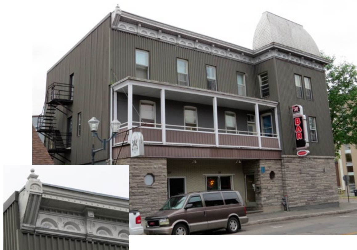
L'Hôtel Blainville en 2014. Une tôle profilée et un matériau qui imite la pierre recouvrent désormais la brique d'origine. Les colonnes tournées, les aisseliers et le garde-corps d'origine sont aujourd'hui disparus. Heureusement, l'imposante corniche métallique (en médaillon), à motifs embossés, est encore avantageusement préservée. 27-29, rue Blainville Ouest.
