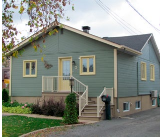
Exemple de maison Wartime Housing, le 2, rue Hertel, Sainte-Thérèse.
