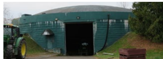
Une porte a été aménagée sur l'ancienne citerne servant désormais à des fins d'entreposage et comme atelier.
