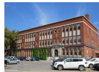
Exemple d'édifice public, le pavillon Notre-Dame au 8, rue Blainville Est, Sainte-Thérèse.
