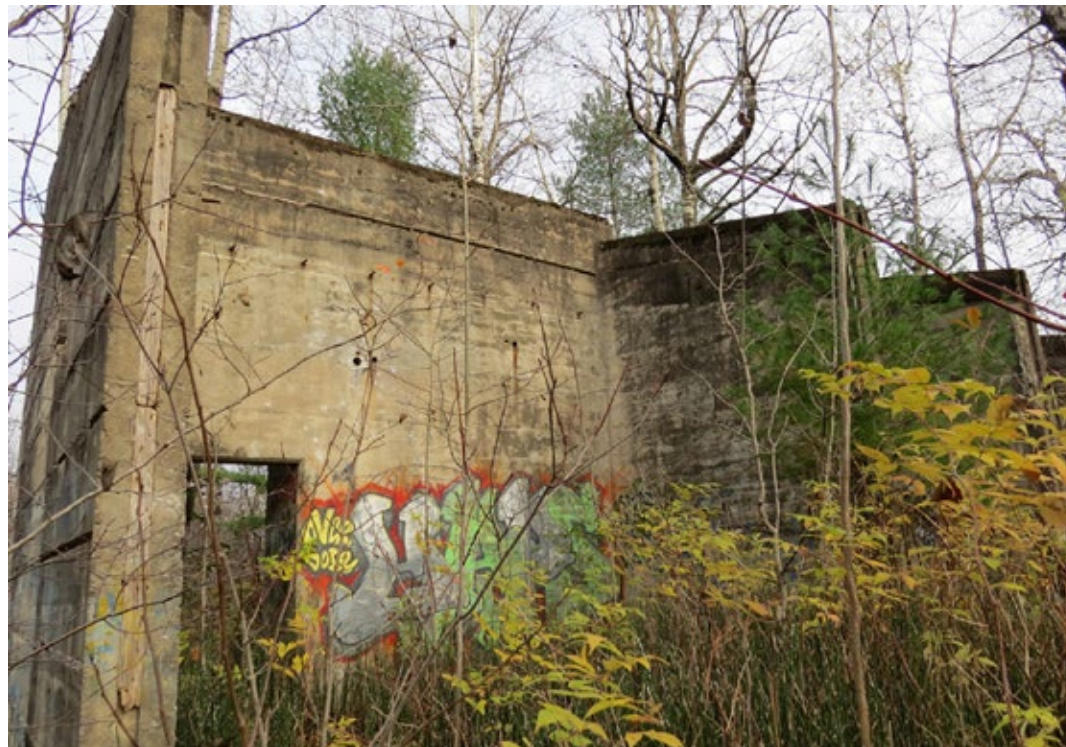
Intérieur d'alcôve de l'un des bâtiments de la structure 2.
